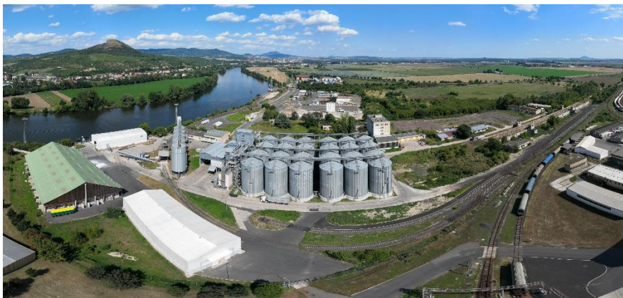
Hafen Lovosice mit neuen Anschlussgleisen (Foto: SBO/CSP)
